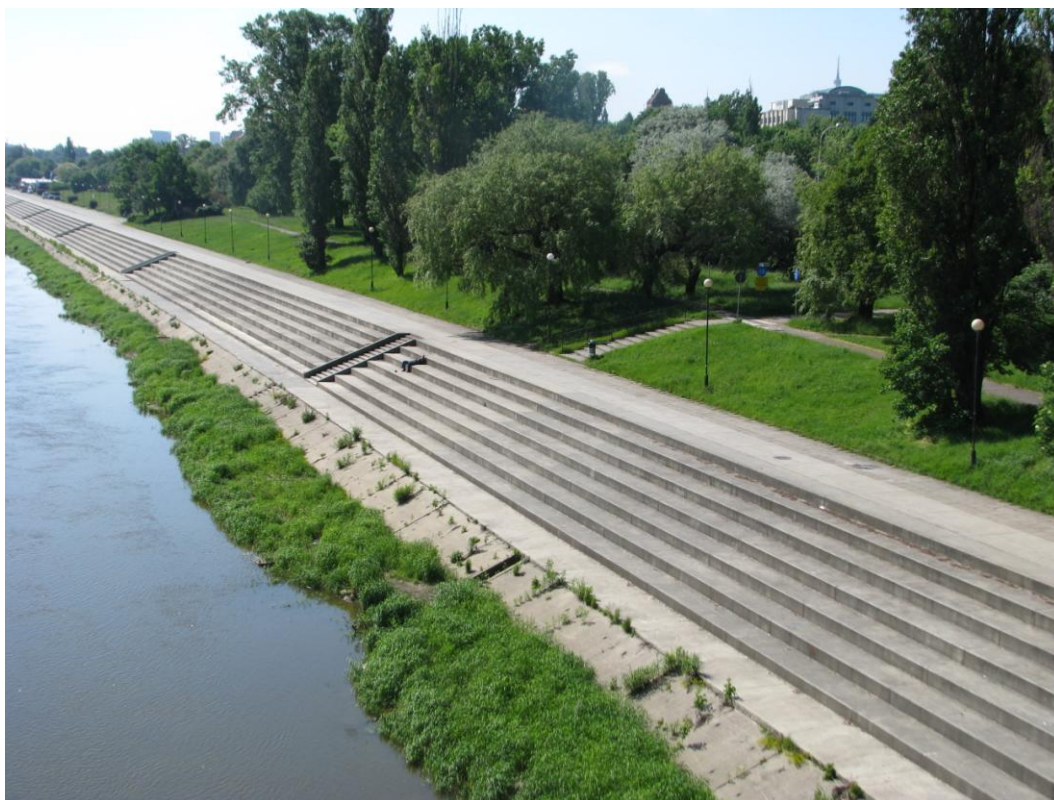
Fot. 21. Opaska jest budowlą regulacyjną usytuowaną równoległe do brzegu. Na zdjęciu opaska, która jest jednocześnie schodkowym bulwarem śródmiejskim w Warszawie (fot. J. Angiel)
