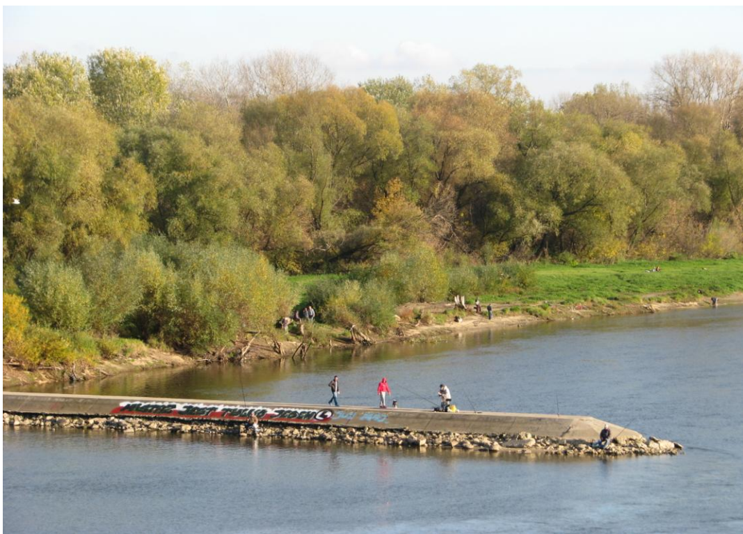
Fot. 20. Ostroga jest sztuczną budowlą powodującą przesunięcie nurtu rzeki pod przeciwny brzeg. Na zdjęciu betonowa opaska na prawym brzegu Wisły w Warszawie (fot. J. Angiel)
