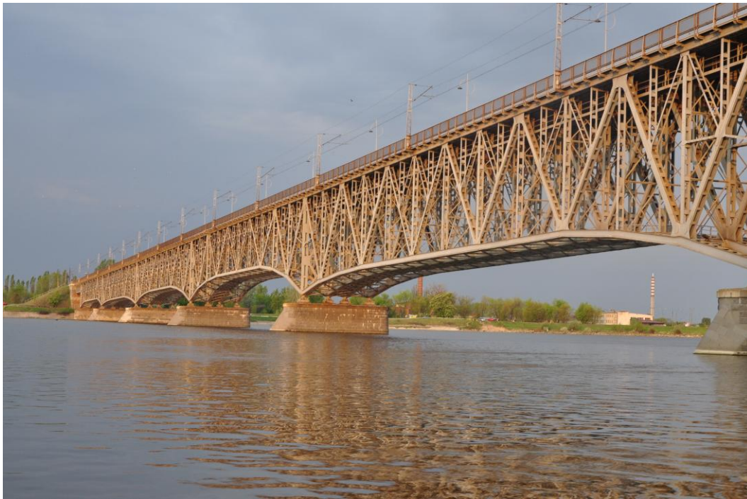
Fot. 16. Płock. Zabytkowy żelazny most im. Legionów Józefa Piłsudskiego zbudowany w latach 1937-1938 (fot. J. Angiel)
