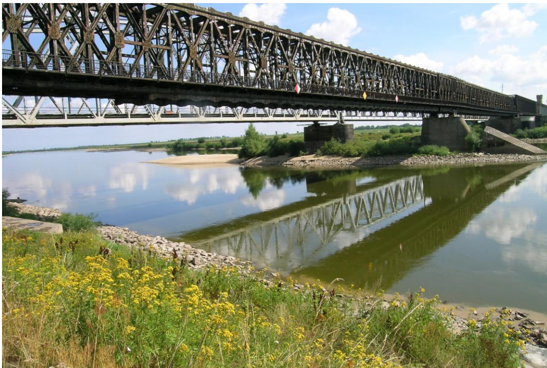
Fot. 17 a. Tczew – zabytkowy most przez Wisłę zbudowany w latach 1851-1857. Uznany w 2004 r. przez Amerykańskie Stowarzyszenie Inżynierów Budownictwa za Międzynarodowy Zabytek Inżynierii Budowlanej. Pierwszy w Europie przykład ażurowego mostu rurowego o wielkiej rozpiętości. Stał się wzorcem w budowaniu podobnych mostów w Europie (fot. J. Angiel).
