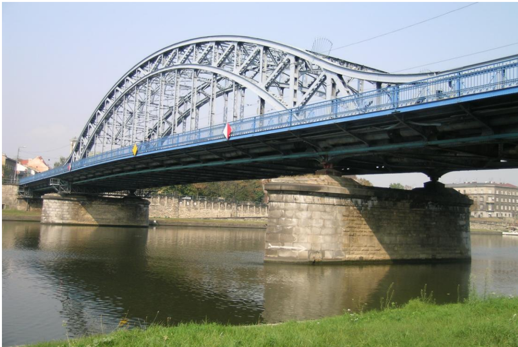
Fot. 14. Kraków. Zabytkowy most im. Józefa Piłsudskiego zbudowany w latach 1926-1933 (fot. J. Angiel)
