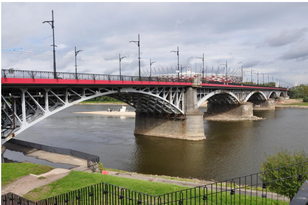
Fot. 15. Warszawa. Zabytkowy most im. Księcia Józefa Poniatowskiego zbudowany w latach 1904-1914 (fot. J. Angiel)
