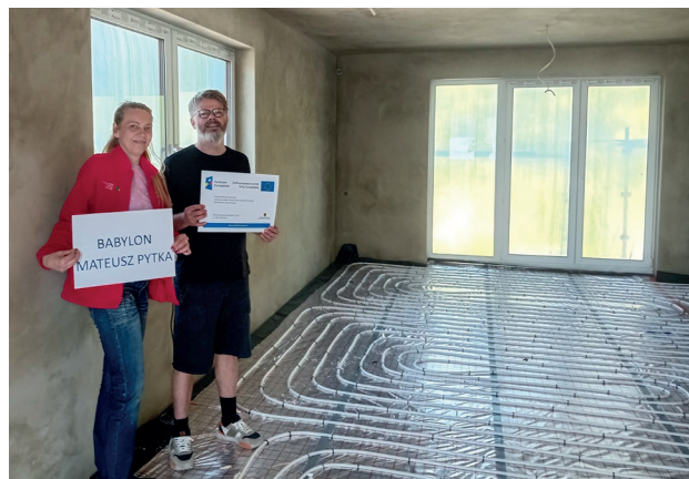
Budowa domu jednorodzinnego, odbiór robót instalacyjnych.
